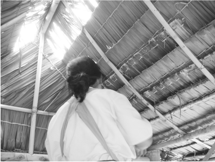
ผู้จำหน่าย ช่วยกันซ่อมแซมหลังคาซุ้ม
