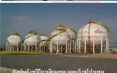
ถังเก็บก๊าซปิโตรเลียมเหลวและก๊าซโพรเพน
